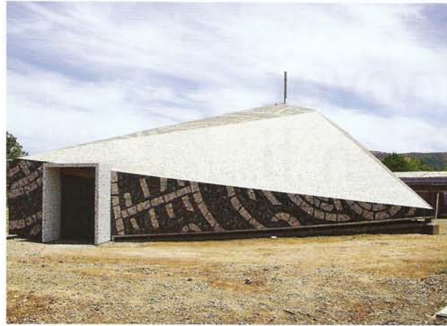
La llamada "Church-Ita", en Chile, es obra del estudio chileno Supersudaca. Se levanta en un barrio difícil y es, prácticamente, una plaza cubierta.
